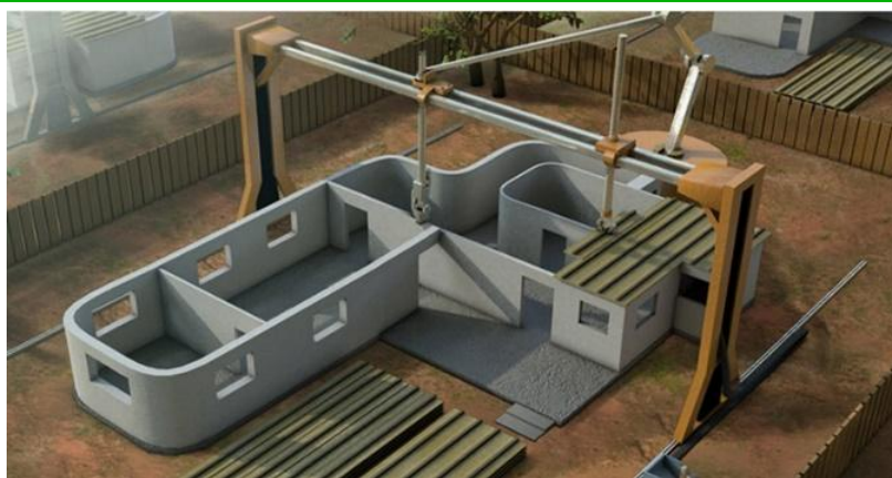
Рис. 3. Система для печати зданий с помощью 3D-принтера
