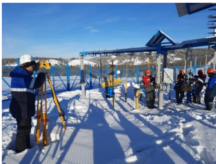
Рис. 1. Проведение мониторинга осадок сооружения способом геометрического нивелирования
