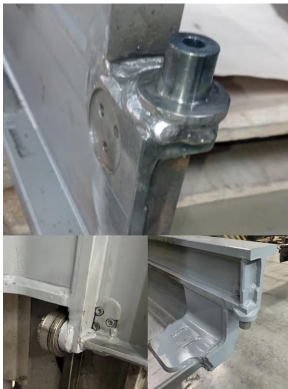
Рис. 2. Устраненное разрушение профиля мачты в местах крепления осей
